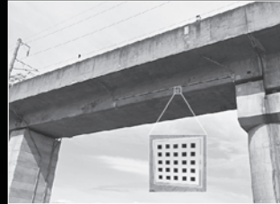
カメラ撮影による橋の変形測定
