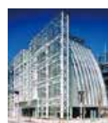
本館 AIST Tokyo Waterfront Main Bldg.
