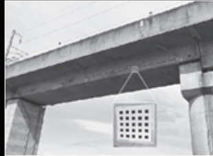
カメラ撮影による橋の変形測定
