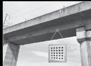
画像解析から橋のたわみを計測するなど、ITを検査技術に統合させることで省力化した診断技術を開発します。
