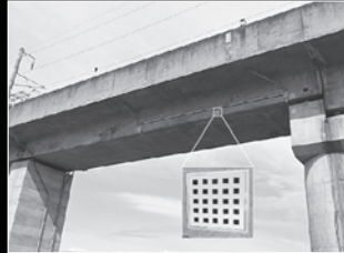
カメラ撮影による橋の変形測定
