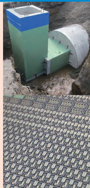
上：埋設作業中の地下式火薬庫モデル (p.8) 下：200 mmウエハー上に作製した圧電MEMSデバイス (p.17)
