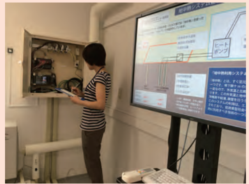
福島再生可能エネルギー研究所の地中熱実験室にて
