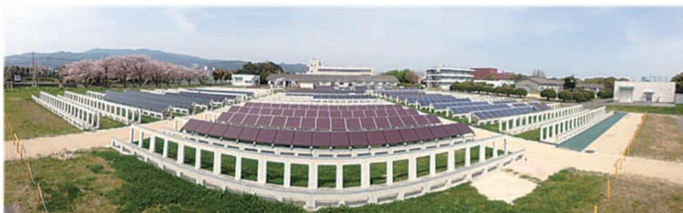
九州センターに設置された8種類10型式の太陽電池モジュールから構成される太陽光発電システムの評価設備
