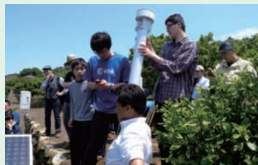
みかん園でフィールドサーバの設置作業
