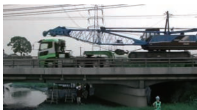
供用中橋梁のモニタリングの様子
