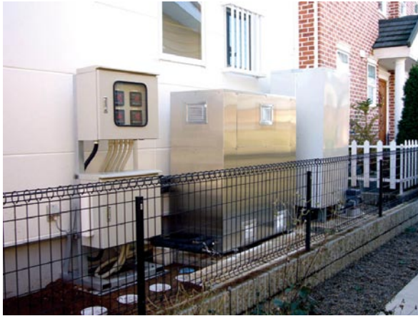
図3 モニター住宅の大地熱源冷暖房・給湯装置 左端から、計測装置、ヒートポンプ、貯湯槽
