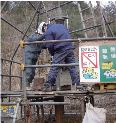
写真2 測定現場での装置の設置風景 作業員2人で十分設置可能である。
