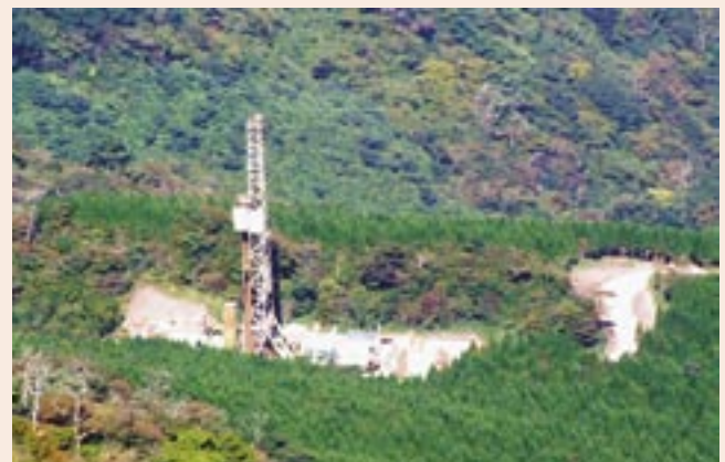
写真 普賢岳北斜面の火道掘削サイト 約2000m 2 の敷地に高さ50mの檣を設置し、国有林内には掘削用の林道を敷設した(写真提供:中田節也氏)。
