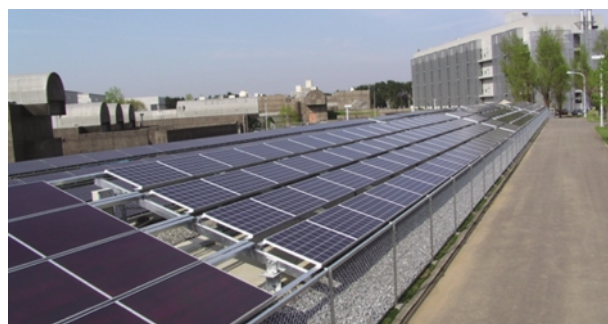
写真 メガソーラタウンの一部。単結晶シリコン、多結晶シリコン、アモルファスシリコンのモジュールが同一条件下で設置されている。
