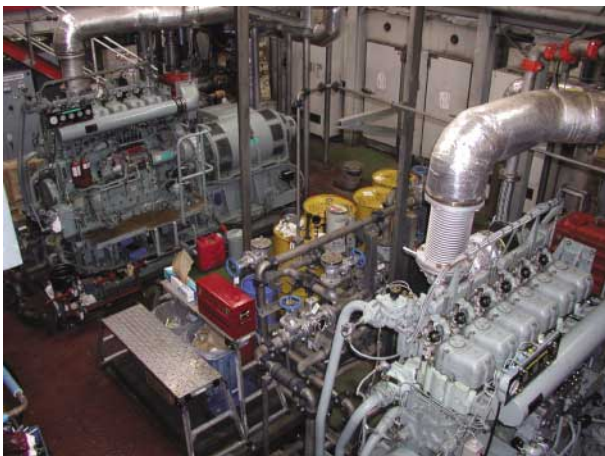
●写真1 設置された2台のS165L-UT 300kVA発電機
