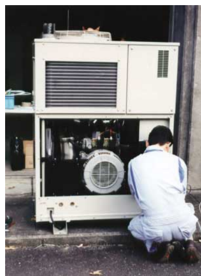
写真 バイオガス利用6kWガスエンジンコジェネの外観
