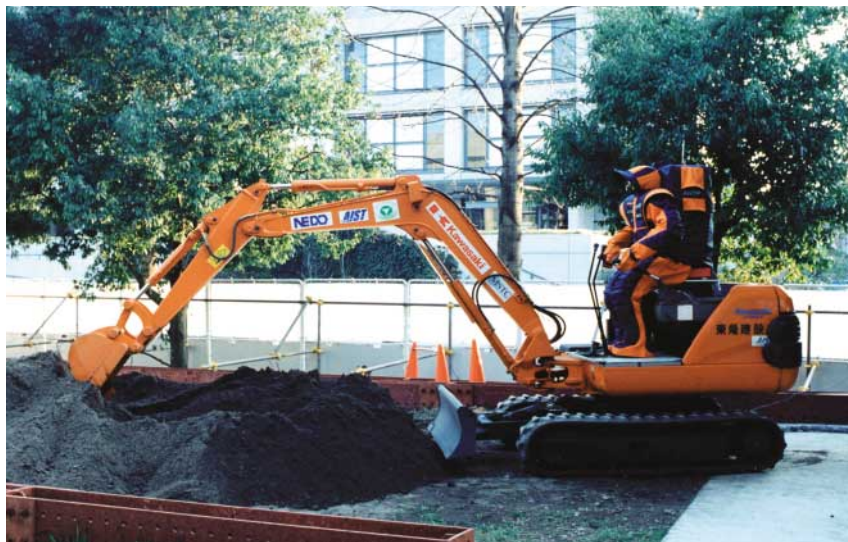
写真 バックホウの遠隔運転
