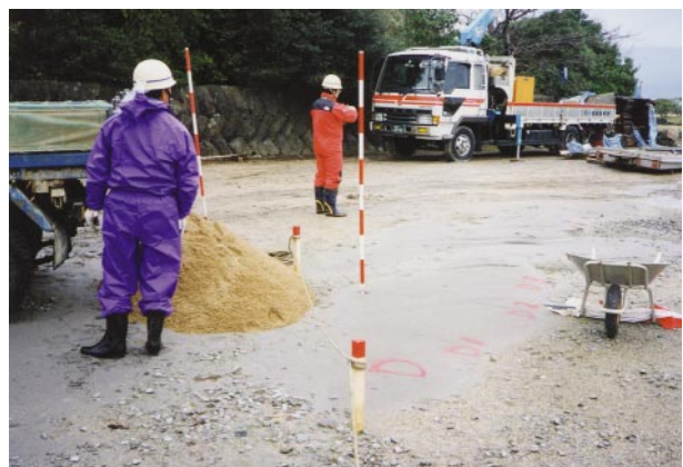
図7 2000年10月6日の鳥取県西部地震による液状化層の調査作業
