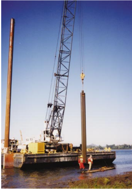
図3 米国北西部コロンビア川沿いのハンチング島におけるジオスライサー調査作業
