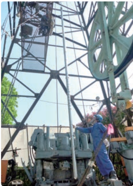
ひずみ計を搭載したこの筒が地中深くに埋められている
