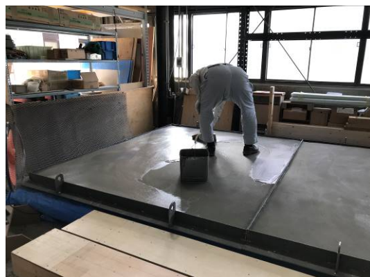
【図2】施工の様子
