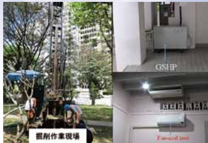
タイ・チュラロンコン大学に設置したGSHPシステム
