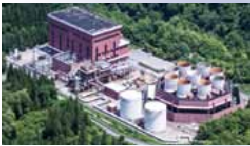
柳津西山地熱発電所 (出典：東北電力株式会社)
