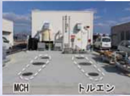
大型貯蔵タンク
