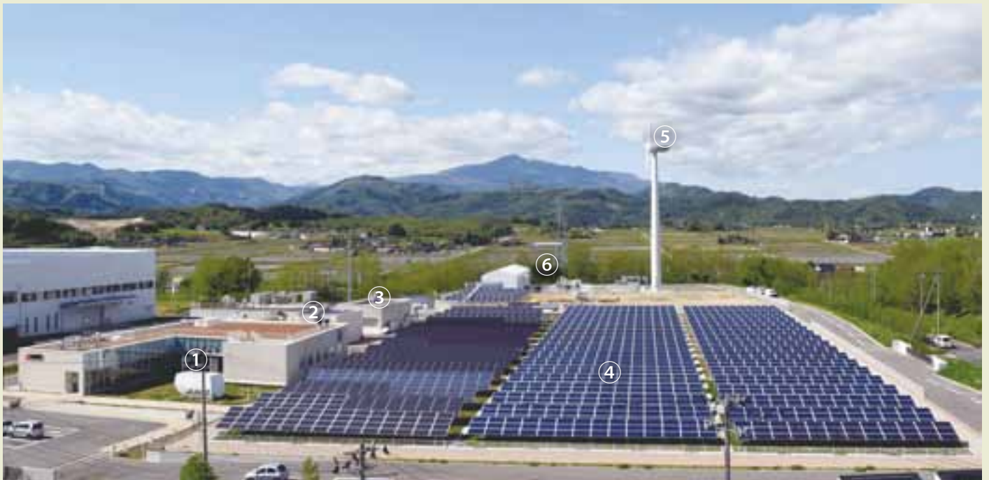
再生可能エネルギー統合実証フィールドの全体写真
