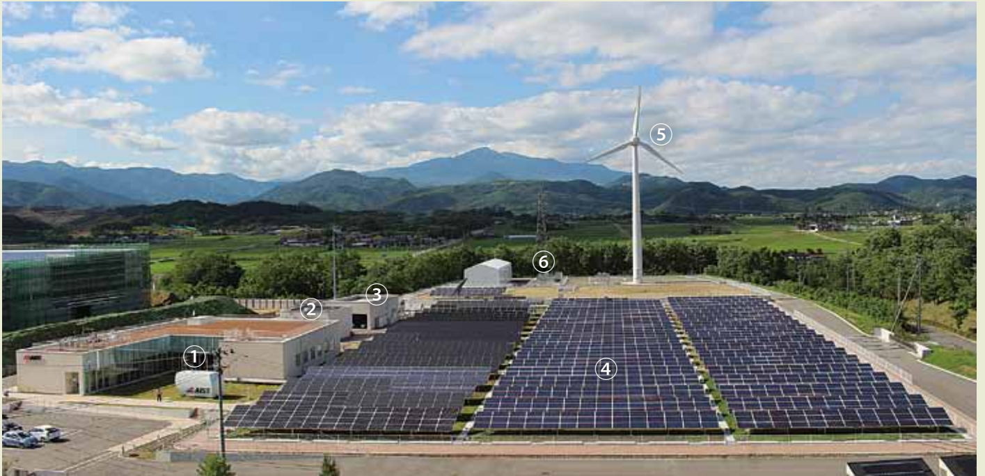
再生可能エネルギー統合実証フィールドの全体写真
