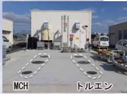
大型貯蔵タンク
