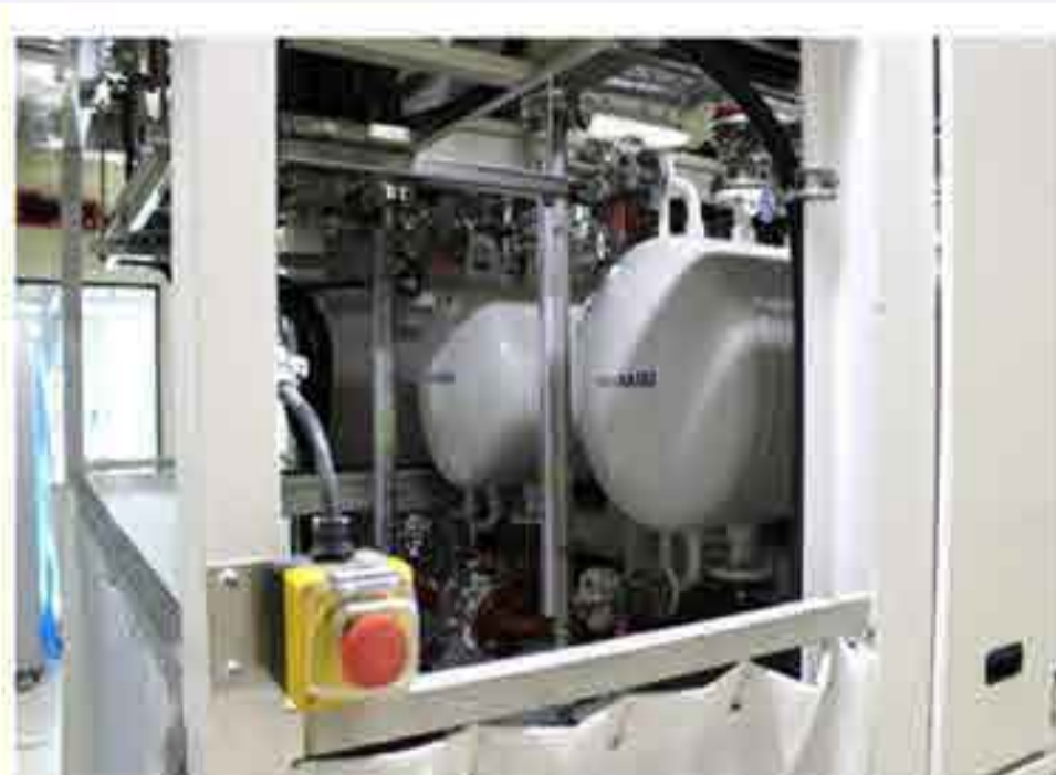
アルカリ電解槽
