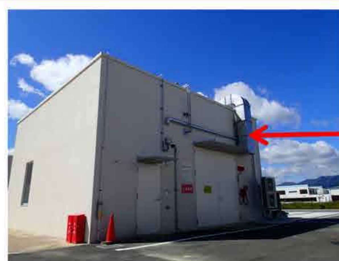
統合システム実験棟
