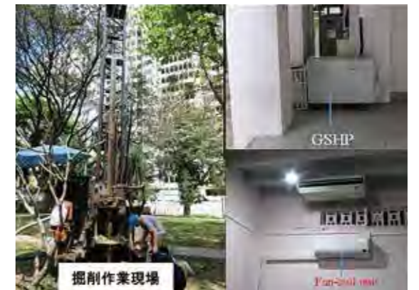
タイ・チュラロンコン大学に設置したGSHPシステム タイ・チュラロンコン大学の施設を利用して、バンコクでも地中熱システムによる冷房運転の可能性を実証しました。 ※GSHP: Ground Source Heat Pump (地中熱ヒートポンプ)の略
