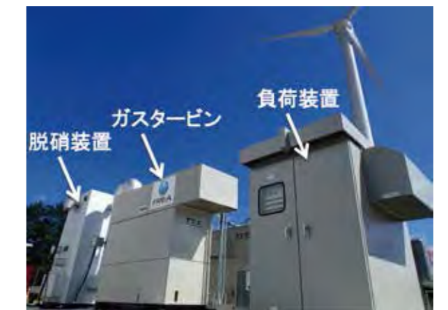
図3 アンモニアガスタービン
