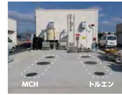
大型貯蔵タンク
