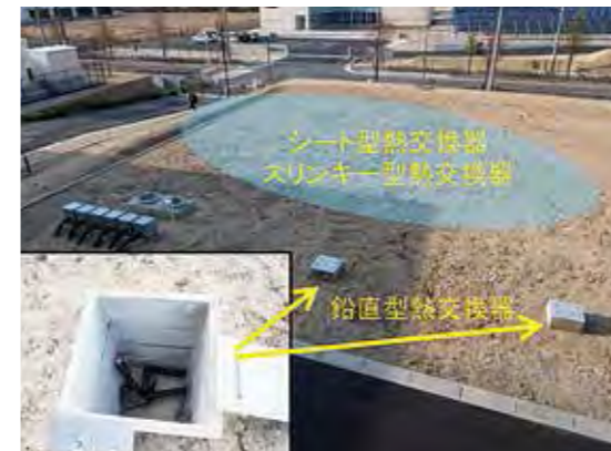
FREA地中熱利用システム実証試験場 深度1~2mの地下に設置するシート型熱交換器とスリンキー型熱交換器および深さ約40mの鉛直型(ポアホール型)の熱交換器を利用した地中熱システムです。
