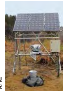
地表設置型3成分地震計の設置状況
