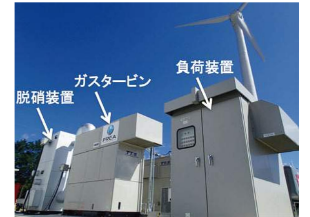
図3 アンモニアガスタービン
