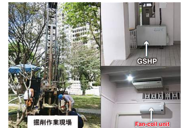
タイ・チュロンコン大学に設置したGSHPシステム タイ・チュロンコン大学の施設を利用して、バンコクでも地中熱システムによる冷房運転の可能性を実証しました。 ※GSHP: Ground Source Heat Pump(地中熱ヒートポンプ)の略
