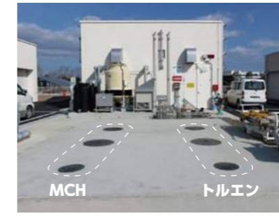
大型貯蔵タンク
