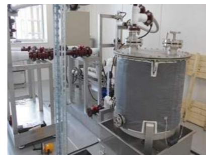
温泉システム模擬装置 温泉の配管系を室内で模擬することが可能です。温泉モニタリング用センサの評価や、温泉発電装置の実験等に使用します。
