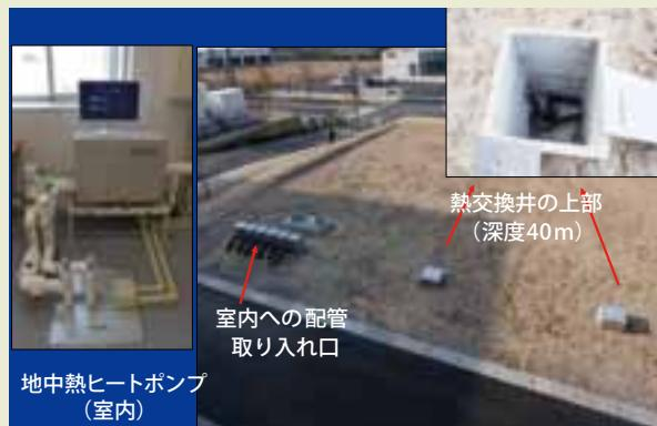
地中熱利用システム実証試験場の概観
