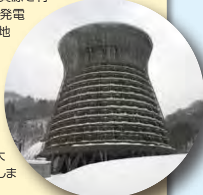
松川地熱発電所(岩手県八幡平市)
