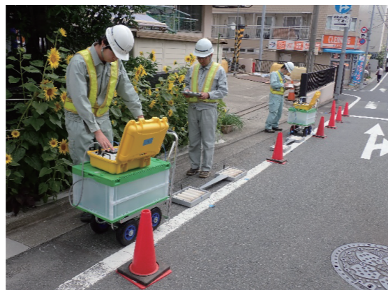
高周波交流電気探査の測定状況
