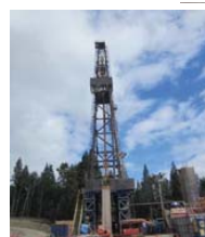
地熱井掘削現場
