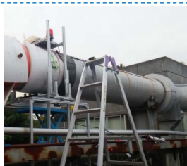
大型配管での実証実験
