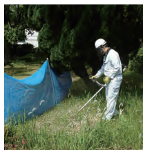
刈払機による除草作業の様子
