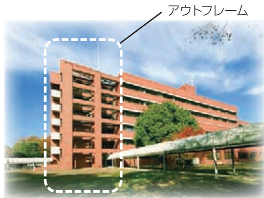
アウトフレーム工法（つくば西-1棟）
