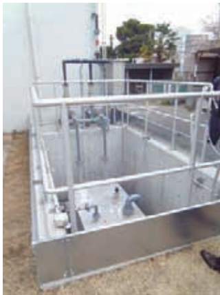
嵩上げたタンクピット
