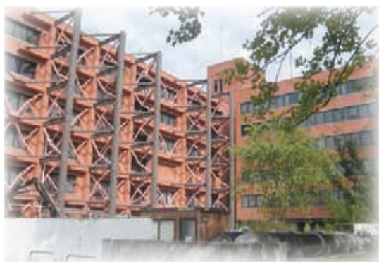
トグル制震工法（つくば中央5-2棟）
