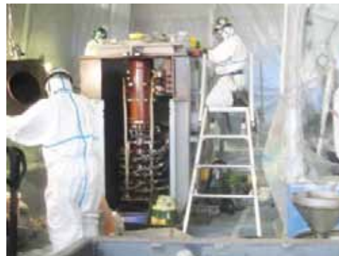
トランスの解体搬出作業の様子
