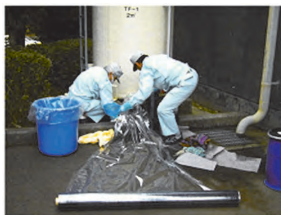
漏えい防止作業の様子
