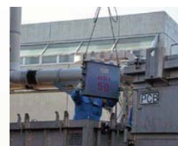
処理委託のための積み込み作業
