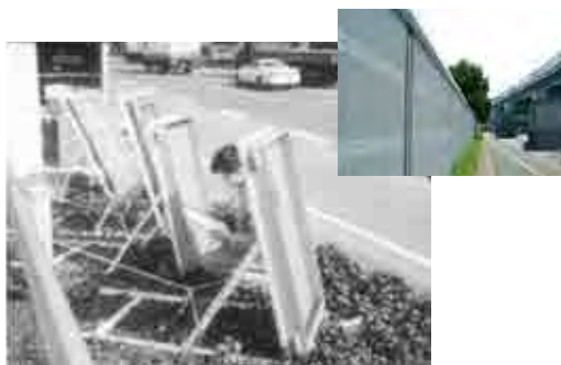
光触媒によるNO x 除去の現地実験風景(左)と光触媒遮音壁(右)
