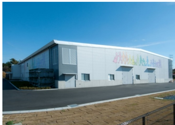
図 15 荻間サイト生活支援ロボット安全検証センター及び付帯設備
