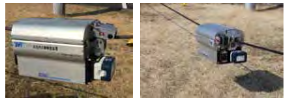
配電線自走式検査試験風景
