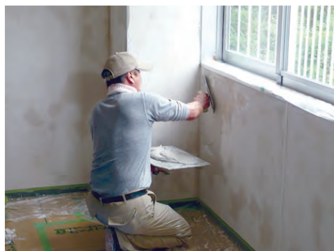
図12 ハスクレイ含有内装仕上材の施工の様子（於：産総研中部センター）
