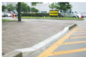
歩道の段差の解消
