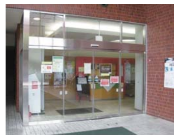
食堂入口のドアの自動化
