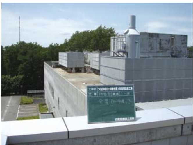
設置した防音壁
