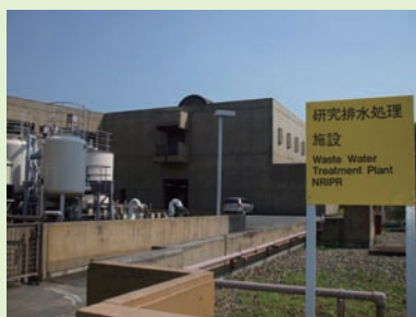
廃水処理施設
