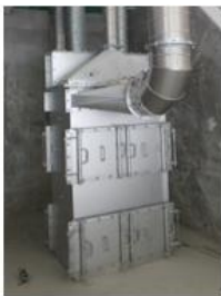
図 熱交換器の外観
