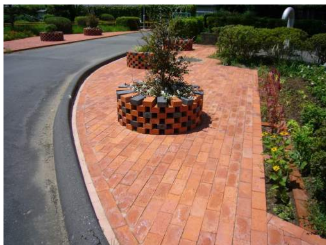
図4 エコレンガの敷設状況 （宮崎県企業局北部管理事務所）
