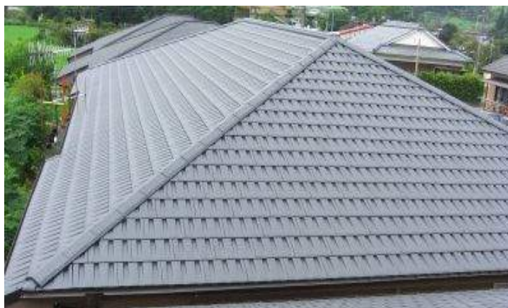
写真2 シラス大判瓦の施工例
