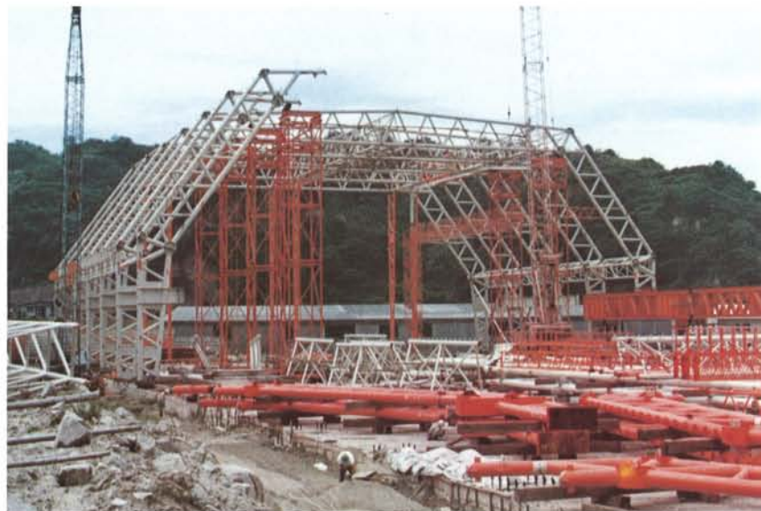
▲建設中の建屋構造体
