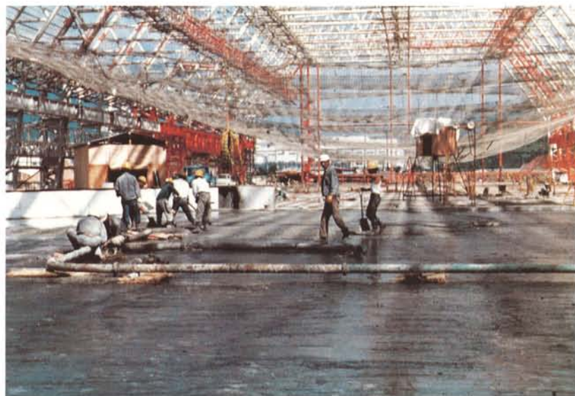
▲模型部防水工事
