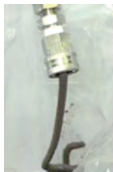
図5 モノポンプによる脱水汚泥供給の様子
