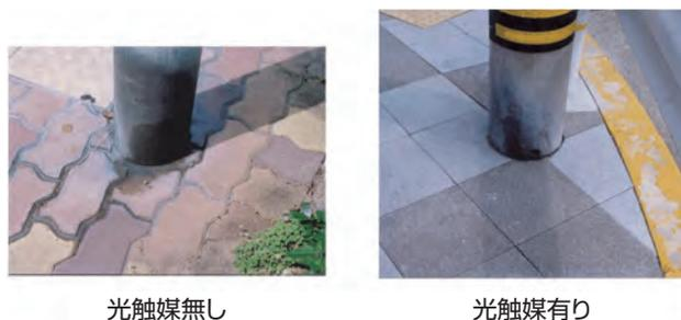
写真3 光触媒透水ブロックの表面の防汚効果 (右)
