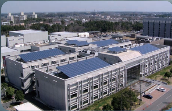
産総研つくばセンターのメガソーラ発電の一部
