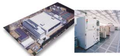
●写真1:スーパークリーンルーム産学官連携研究棟の全景と研究クリーンルームの内部
