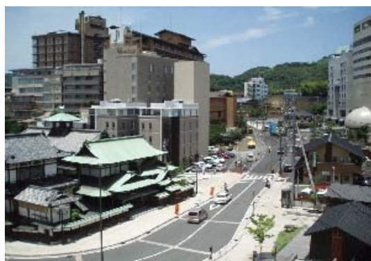
道後地区 整備後の様子 (出典：愛媛県庁HPより)
