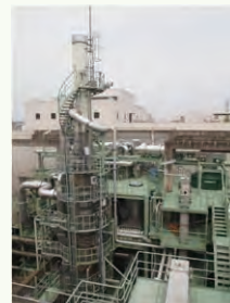
稼働を開始したプラント
